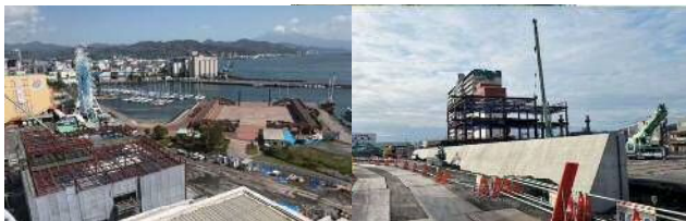
防潮堤建設現場
